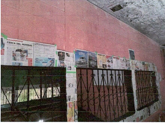
Rubro No. 5: Mejoramiento de Ventanas
