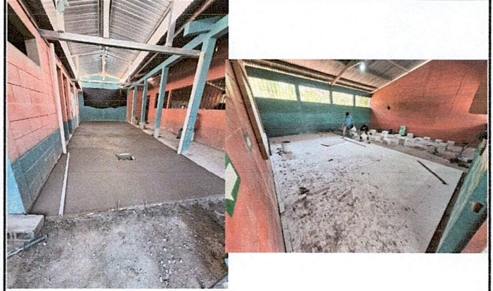
Rubro No. 6 Mejoramiento de piso
