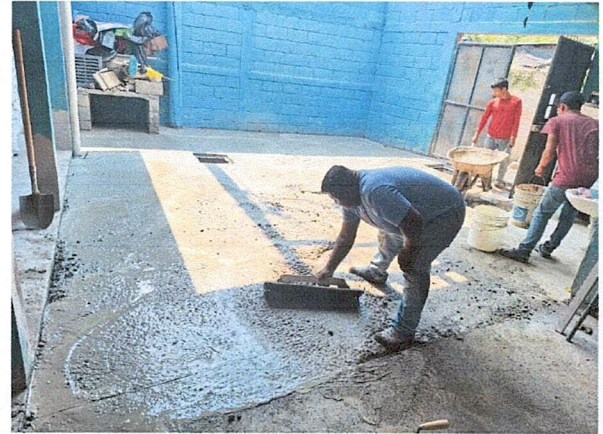
Rubro No. 16 Mejoramiento de Losa de Patio
